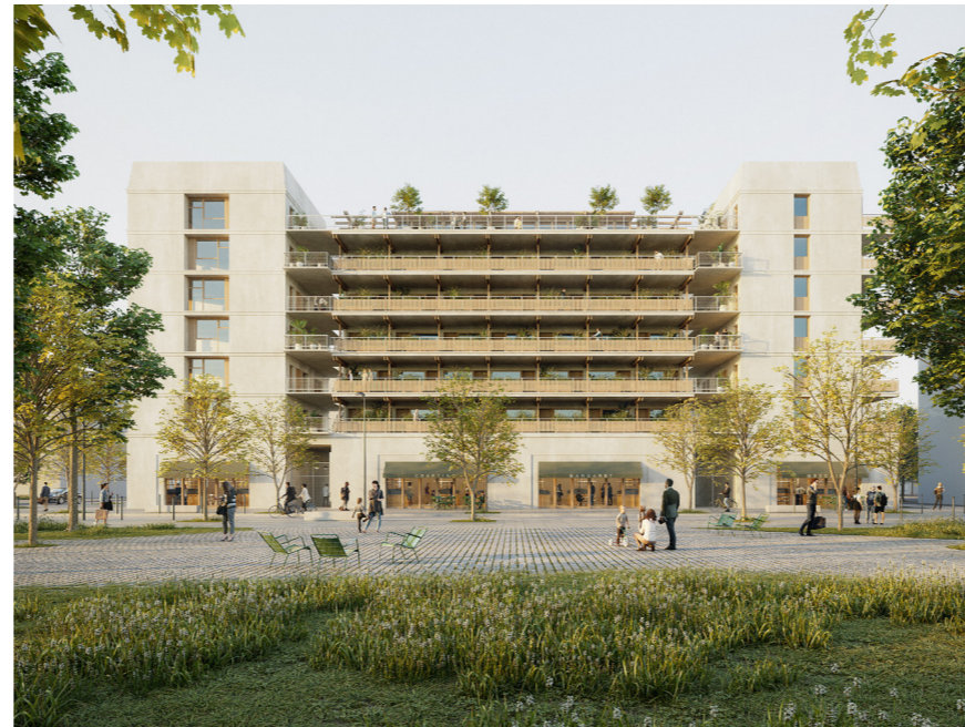
MONTPELLIER MOSSON 72 Logements intergénérationnels Bois
