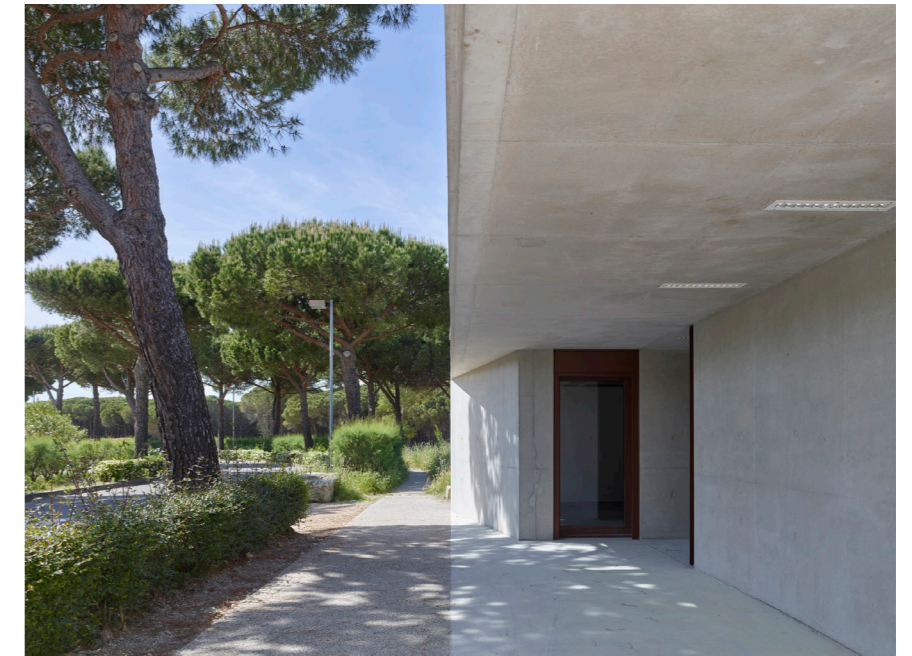
LA GRANDE-MOTTE Maison des jeunes Béton
